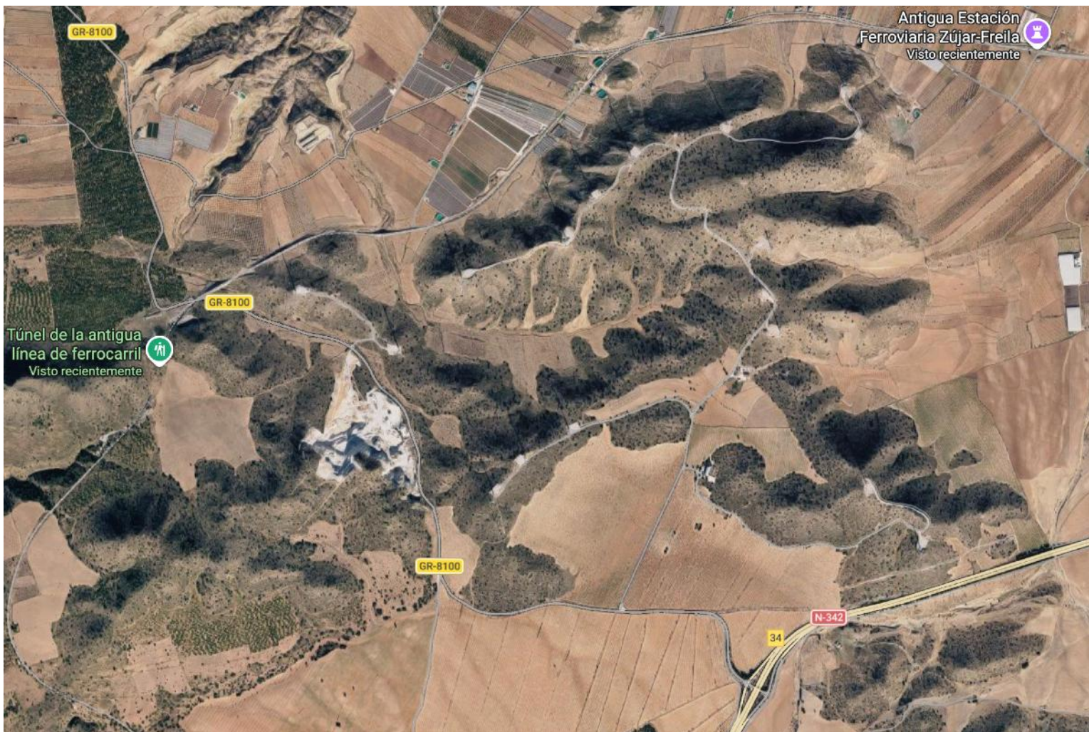
Túnel de la antigua línea de ferrocarril. Cortijo del Túnel, Freila
